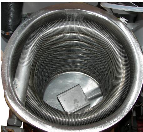
Der Wärmetauscher ist jetzt zur Reinigung zugänglich.
