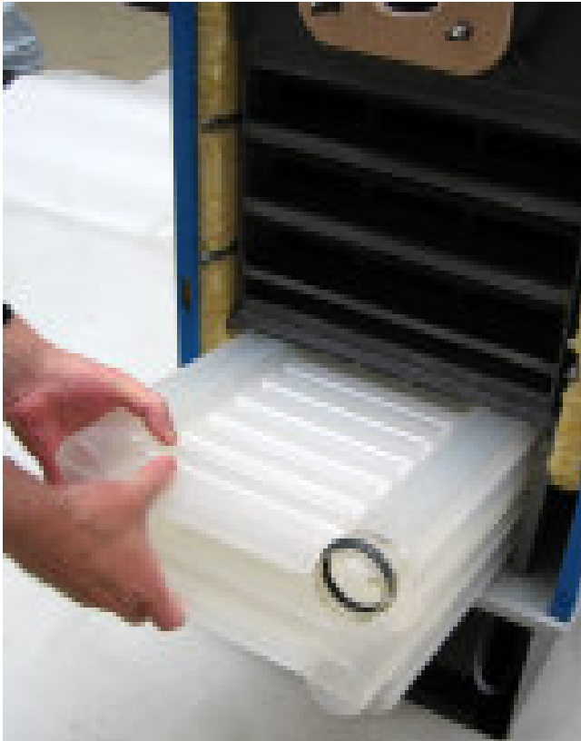
Bild 3-14: Demontage des Kunststoff-Wärmetauschers zur Inspektion/Reinigung.
