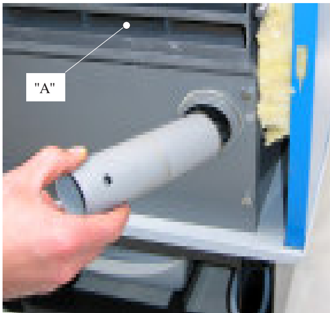
Bild 3-10: Zuluftrohr zur Demontage des Kunststoff-Wärmetauschers herausziehen.
