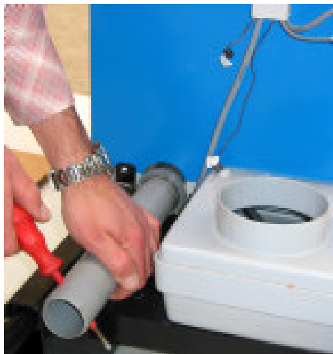
Bild 3-13: Demontage des hinteren Zuluftrohrs.
