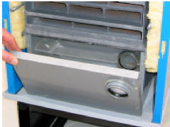
Bild 3-12: Demontage der Stützrahmen-Vorderwand zur Inspektion/Reinigung des Kunststoff-Wärmetauschers.
