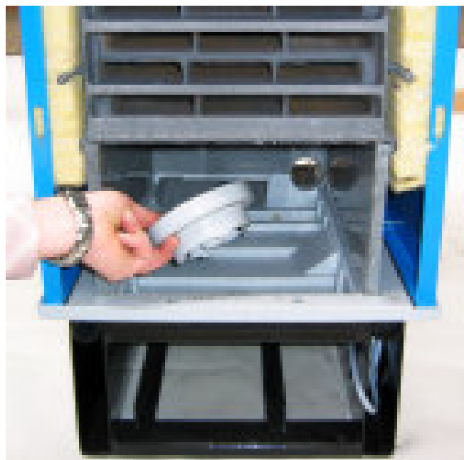
Bild 3-16: Inspektion/Reinigung von Bodenwanne und lose aufgesetztem Geruchsverschluß, nach vorheriger Demontage des Kunststoff-Wärmetauschers.
